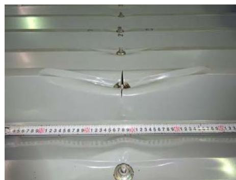
写真2 屋根葺き材固定部での破損状況
